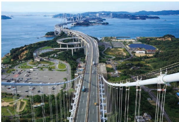
「瀬戸大橋」 撮影者／盛中 幹雄 撮影場所／香川県坂出市
